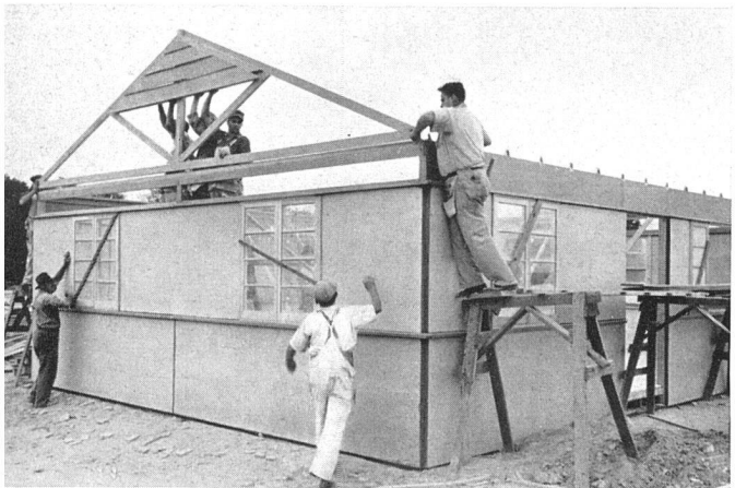
Montage der verputzten Wandelemente und Dachbinder
