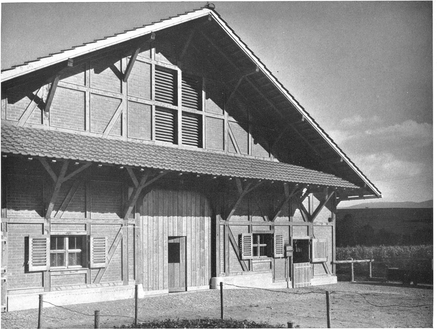
Westliche Giebelfront, unverputzter Riegelbau
