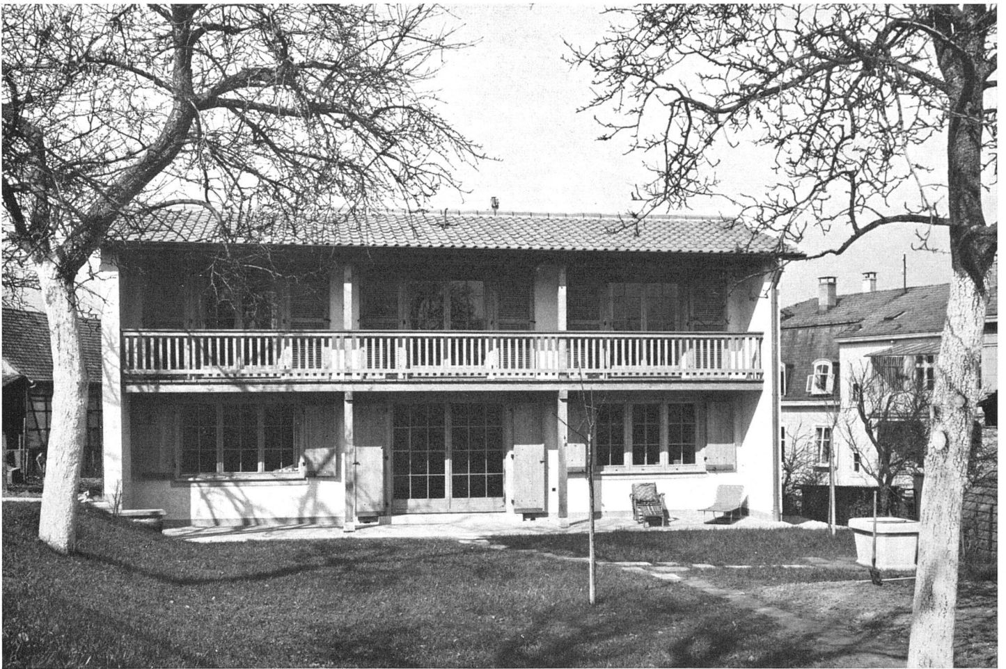
Gesamtansicht von Süden
