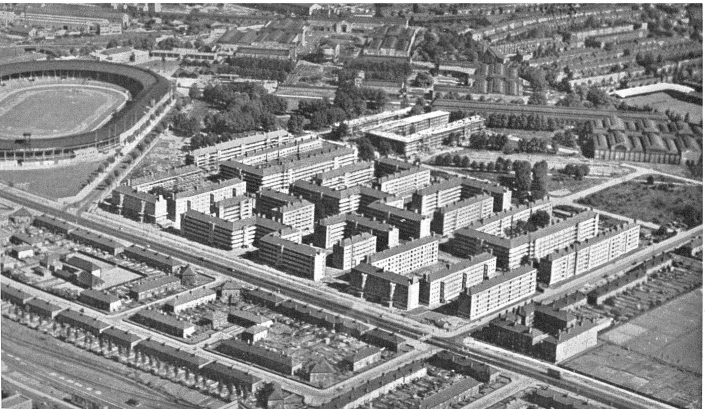
Nouveau quartier d'habitation (avec 5 étages) à Hammersmith, réalisé par London County Council 1936-1939. Densité: 524 habitants par hectare
