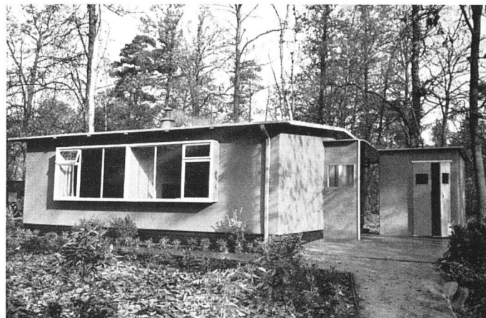
Bungalow terminé à destinée provisoire
