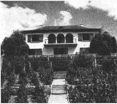
Villa à Awernier. Fernand Decker, arch. FAS, Neuchâtel
