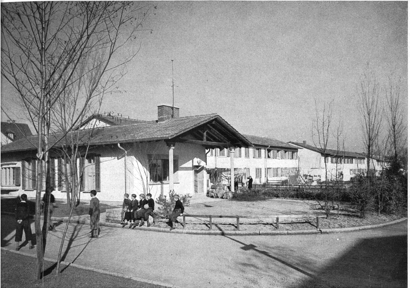
Siedlung der ABZ in Oerlikon A. & H. Oeschger, Architekten BSA, Zürich Kolonielokal mit Kinderspielplatz
