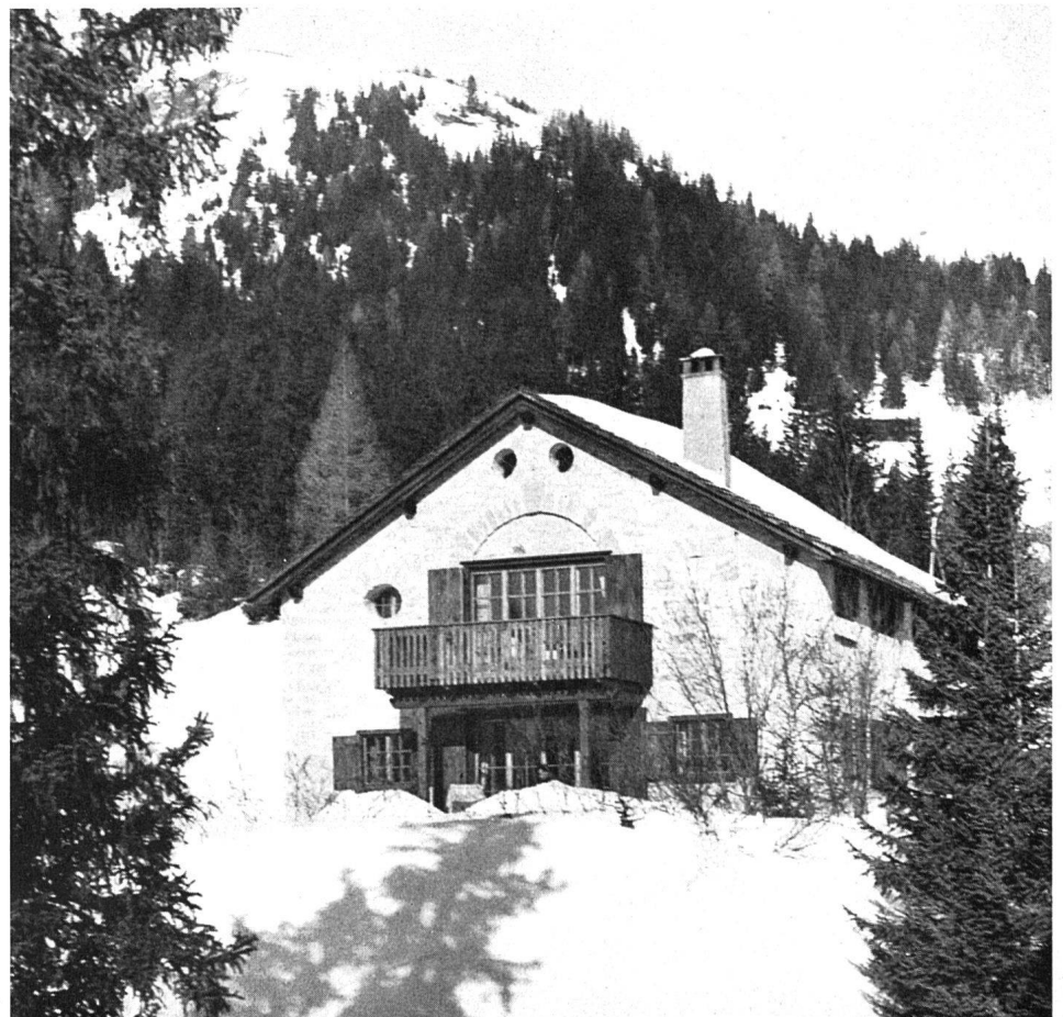
Südliche Giebelseite mit Balkon und Terrasse
