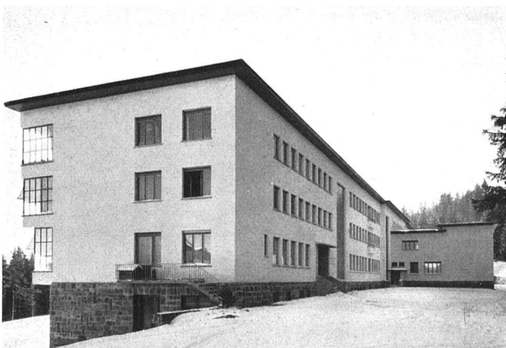
Ansicht von Nordost mit Eingang der Männerabteilung
