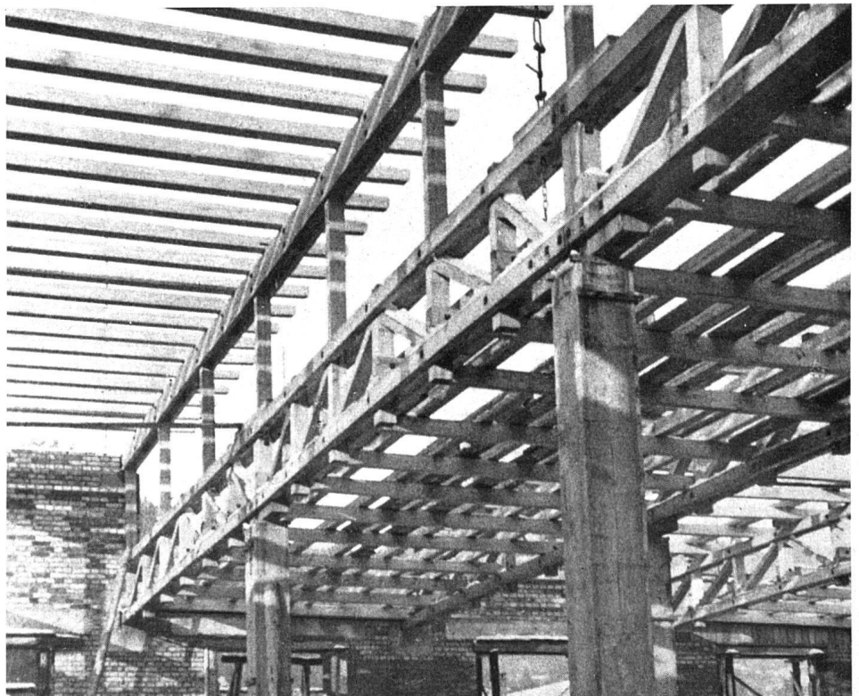
Holzkonstruktion der Laternen und Decke, Säulen in Eisenbeton
