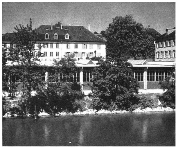
Neubau an der Limmat
