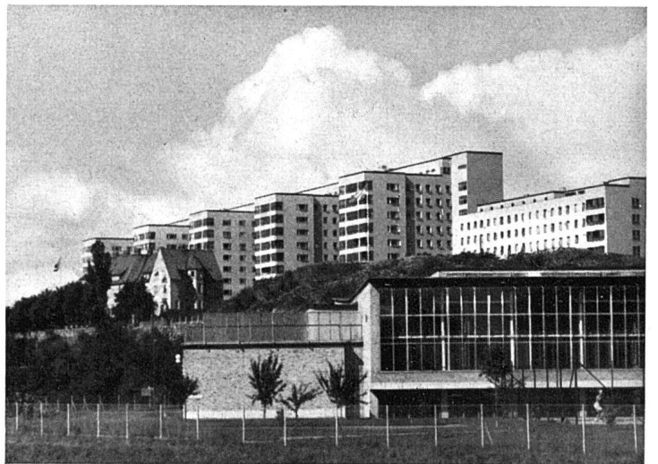
Abb. 7 und 8 Söderkrankenhaus Stockholm, Süd- und Zugangsfront
