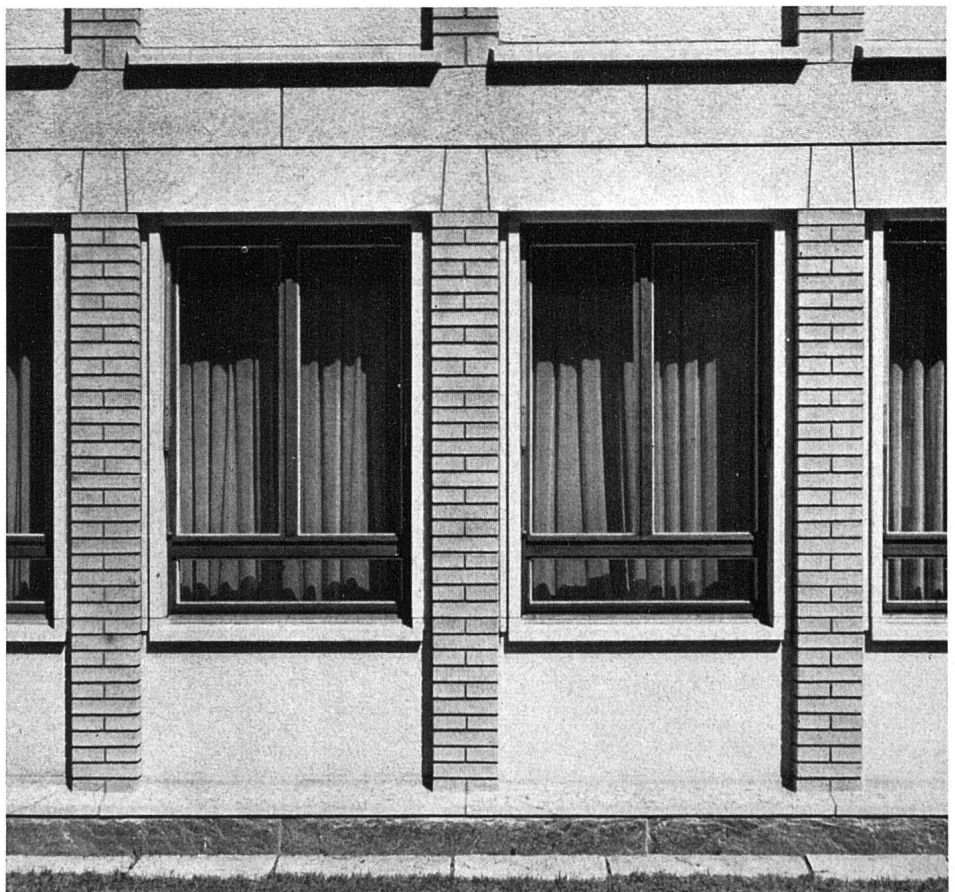
Abb. 29 Detail zu Abb. 28 Gebäudesockel und Stockwerksgurt in Granit, Pfeiler in Kalksandsteinmauerwerk, Fenstergewände in weißem Kunststein, Brüstungsfelder weiß verputzt
