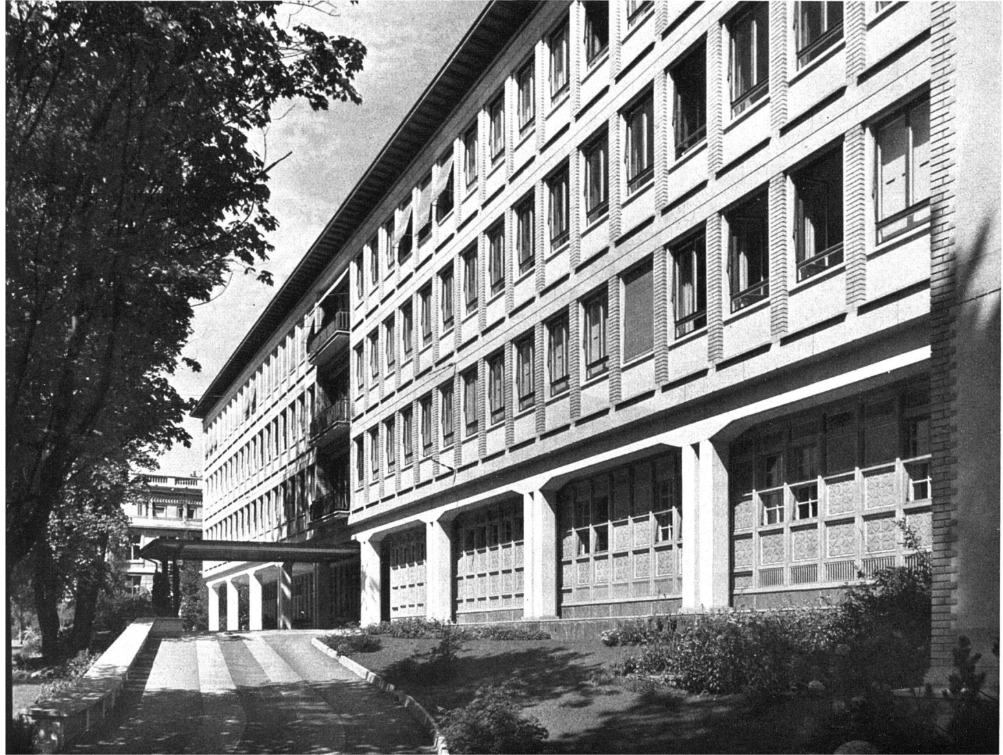
23 Westfront mit Aufgangsrampe und Haupteingang
