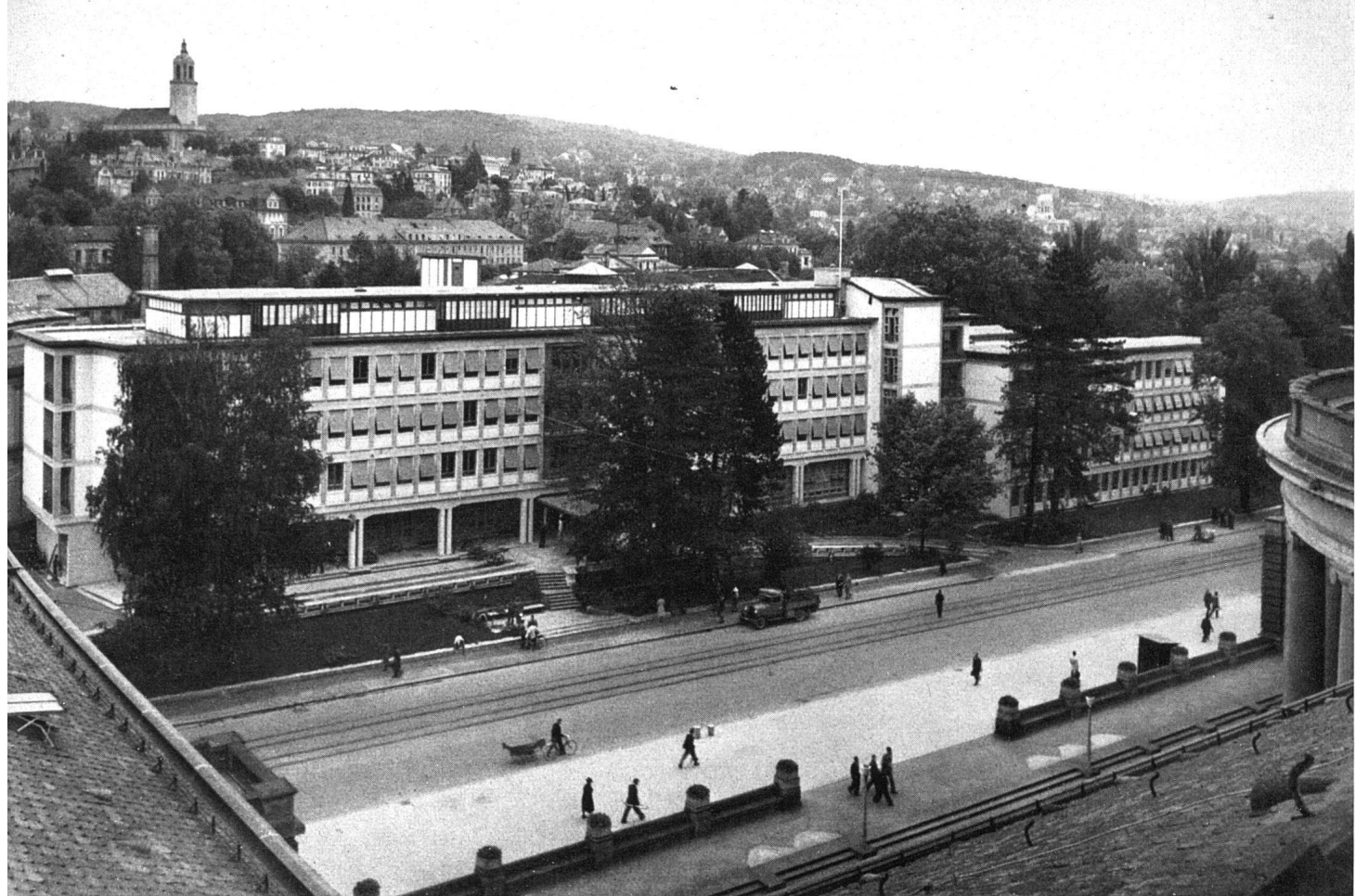
22 Gesamtansicht des Polikliniktraktes mit Rämistraße ( von der Dachterrasse der ETH aus )
