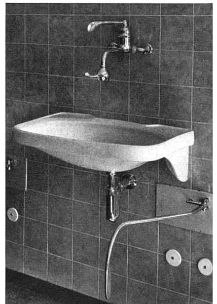
Abb. 82 Operationswaschtisch, neues flaches Modell AKZ (Fabrikat Kerawerke AG. Laufenburg) mit großem Wandabstand, auf 1,10 m Höhe montiert. Warmwassersparende Mischwasserbatterie (Modell H. U. Bosshard AG.). Das Wasser fließt nur, so lange der Kniehebel bedient
