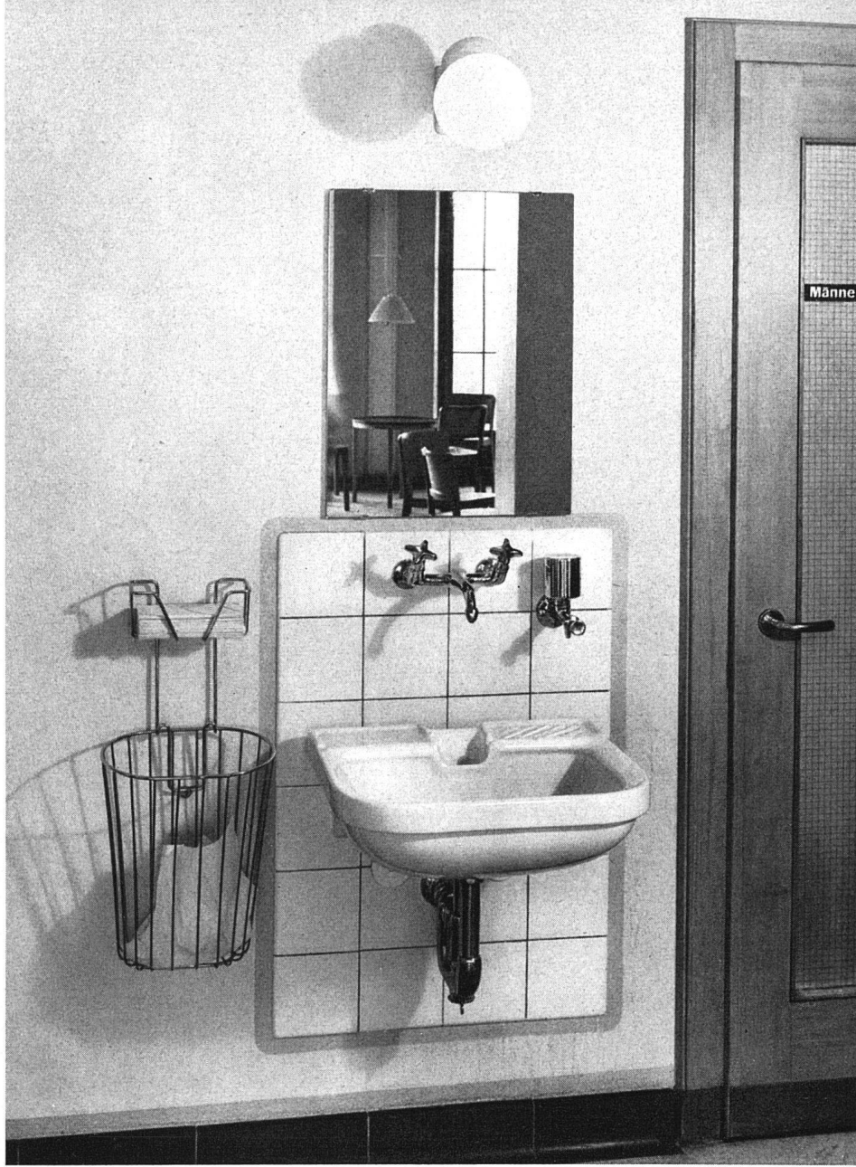
Abb. 79 Waschgelegenheit im Toilettenvorplatz. Standard-Anordnung für den ganzen Bau, gültig bezüglich Apparat, Garnituren, Wandplatten und Beleuchtungskörper
