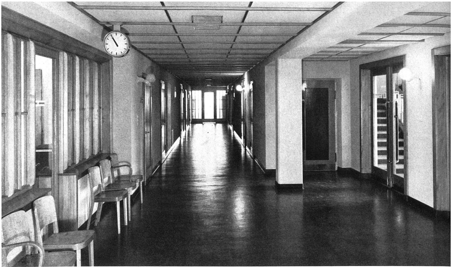
Abb. 45 Normalkorridor beim Anschluß des zukünftigen Bettenhauses. Die Decken sind hier gegenüber der normalen Raumhöhe von 3,00 m 2,45 m als demontable Paneele (Pavatex mit Naturholzrahmen) herabgesetzt (Hohlraum für Leitungen, Verringerung des Nachhalls, räumlicher Kontrast zu den Zimmern). Bodenbelag aus Korkplatten
