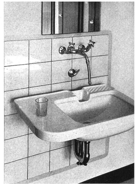
Abb. 81 Normaltoilette AKZ mit Abstellfläche (Fabrikat Laufen; Armatur Karrer, Web Co., siehe «Werk» Nr. 5 1946 und «Installation» Nr. 4 1946). Gleiche Toilette Abstellfläche siehe Abb. 79. Für beschränkte Platzverhältnisse hat die AKZ ausserdem Kleintoilette (Fabrikat Laufenburg) gesch
