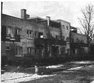
Reihenhäuser, 1920 von Architekt J. B. van Loghem († 1940)
