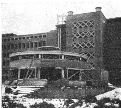
Verwaltungsgebäude der Bataafsche Import-Gesellschaft 1939/40, von Architekt J. J. P. Oud. Rückansicht mit runder Personalkantine, Bau stark durch Bomben beschädigt. Streng symmetrische Anlage, Formversuche à la art décoratif
