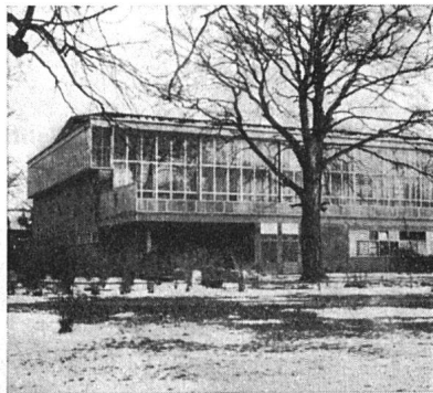
Hallenbad 1932, von Architekt J. B. van Loghem. Die Badehalle kann durch große Schiebewände nach der Sonnenterrasse geöffnet werden. Bau während des Krieges ungenügend unterhalten
