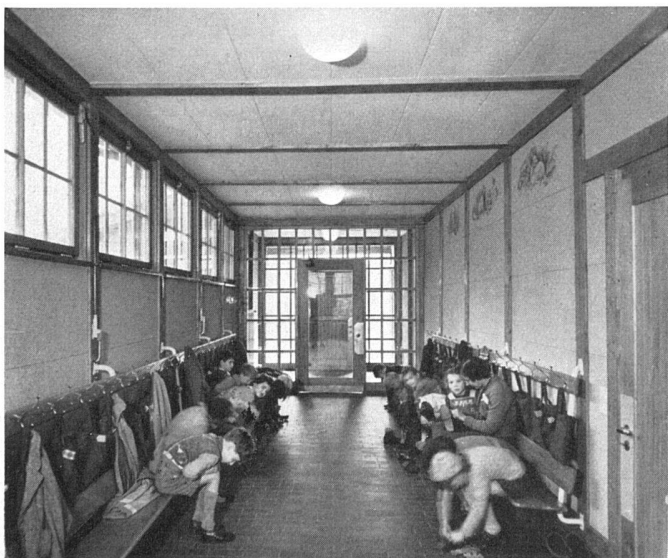
Abb. 21 Garderobe mit Sitzbänken und Kleiderhaken | Vestiaire avec bancs et crochets pour les habits | Cloak-room with benches and coat hooks
