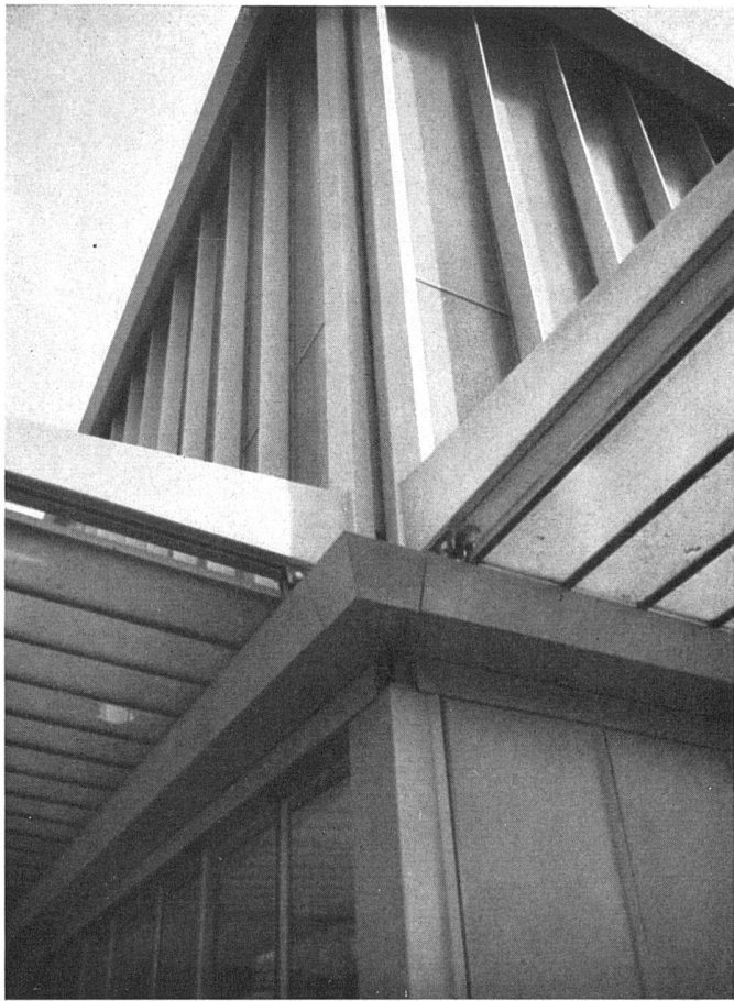
Gebäudeecke, Detail / Un coin du bâtiment / A corner of the building
