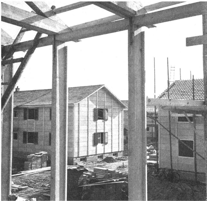
Holzskelett und halbfertige Bauten / Ossature en bois et deux unités en construction / Wooden framework and two units under construction
