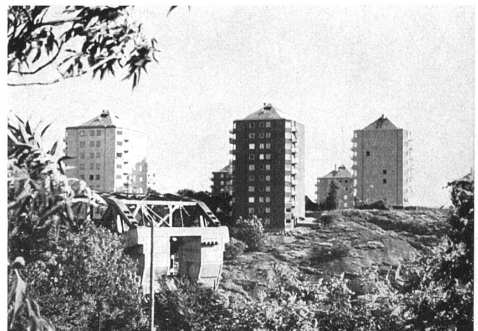
Ansicht von Norden | La cité vue du nord | View from the north
