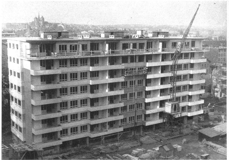
Groupe L 1948/49, en construction, façade sud-ouest / Wohnblock L (im Bau), Südwest-Ansicht / Block of flats L, South-west elevation (under construction)
