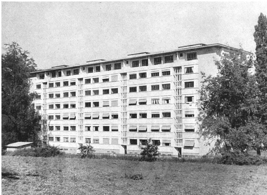
Groupe K, façade nord-ouest / Wohnblock K, Nordwest-Ansicht / Block of flats_K, North-west elevation
