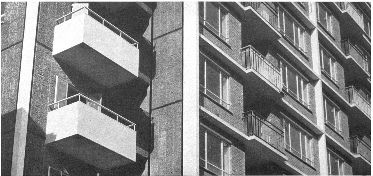
Fassadenausschnitt. Fassadenverkleidung links aus vorfabrizierten Betonplatten mit eingelegtem Ziegelschrot, Betonflächen weiß | Partie de la façade sud. Les façades de gauche sont revêtues de dalles en béton préfabriquées et dont la surface est composée de débris de brique | Part of south elevation. The flank façades at left are clad with prefabricated concrete slabs with a surface composed of broken brick.
