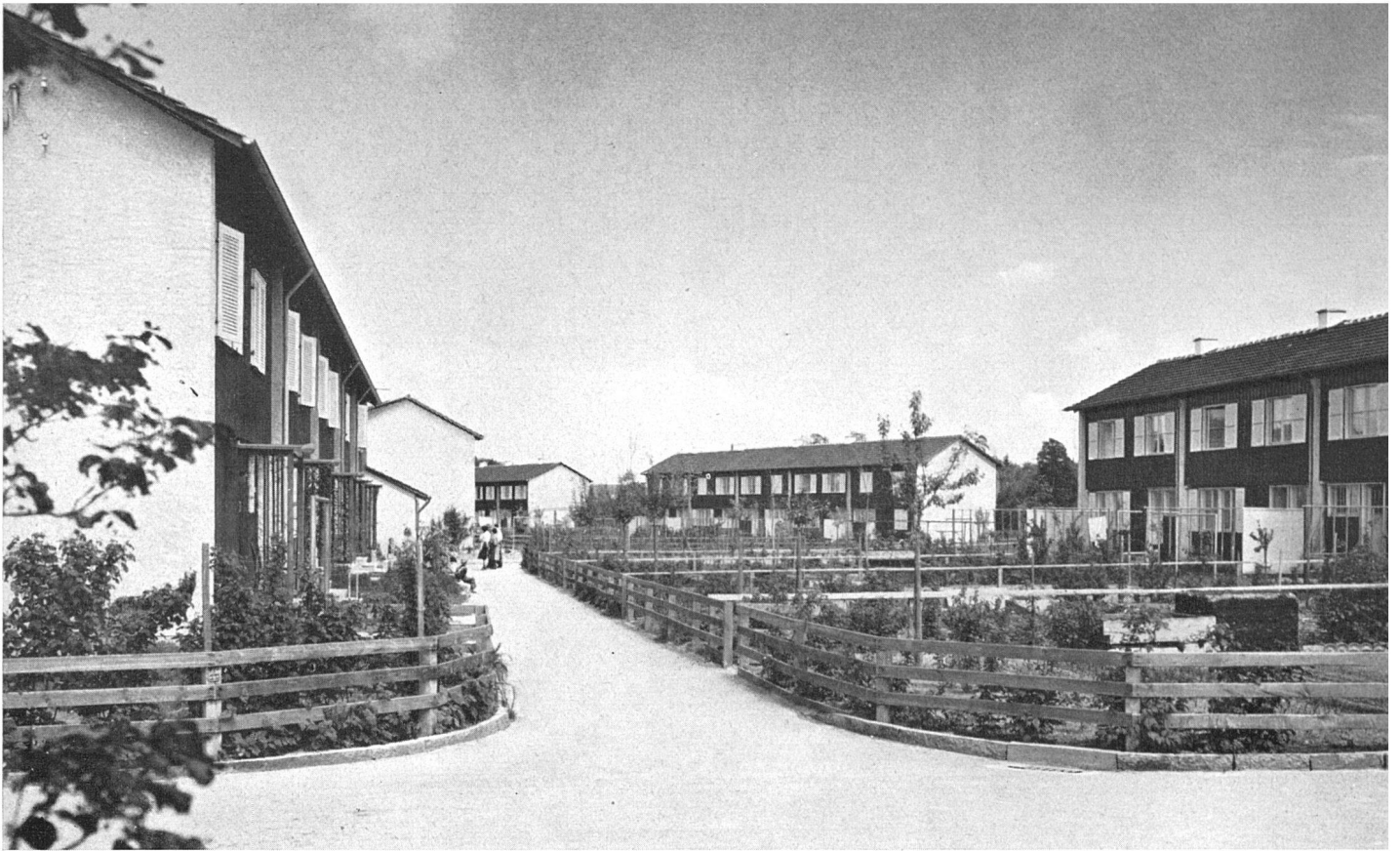
Blick in den Siedlungsraum von Süden / La cité vue du sud / The scheme seen from the south
