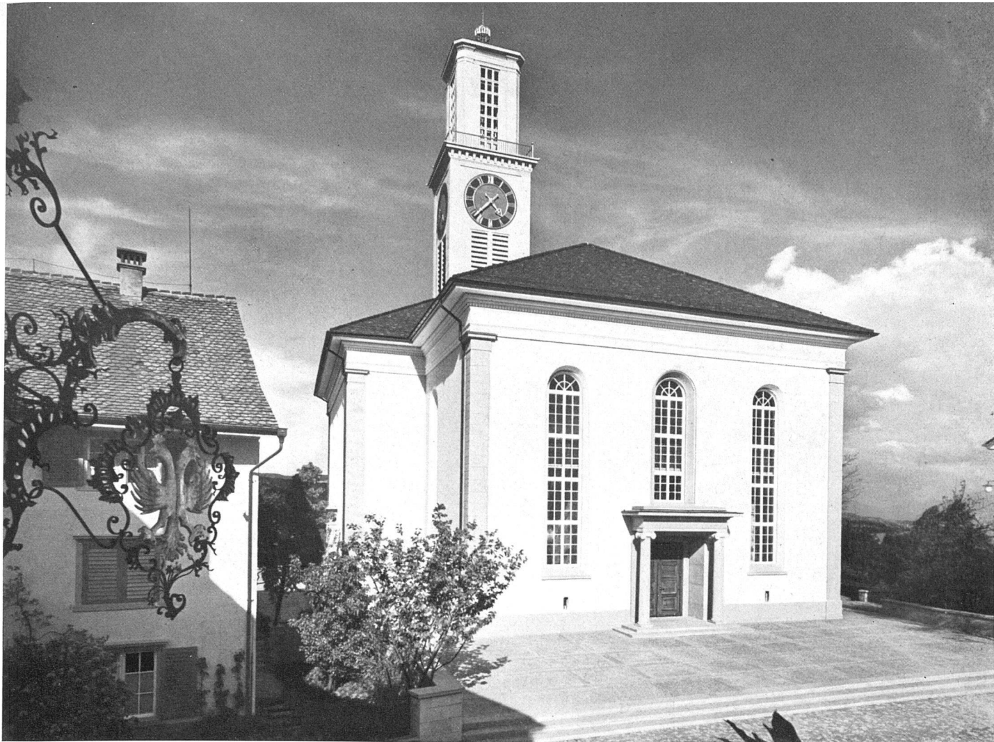
Gesamtansicht mit Eingang vom Dorfplatz / Ensemble et porche, vue de la place du village / General view and entrance from the village square Photos: M. Wolgensinger SWB, Zürich
