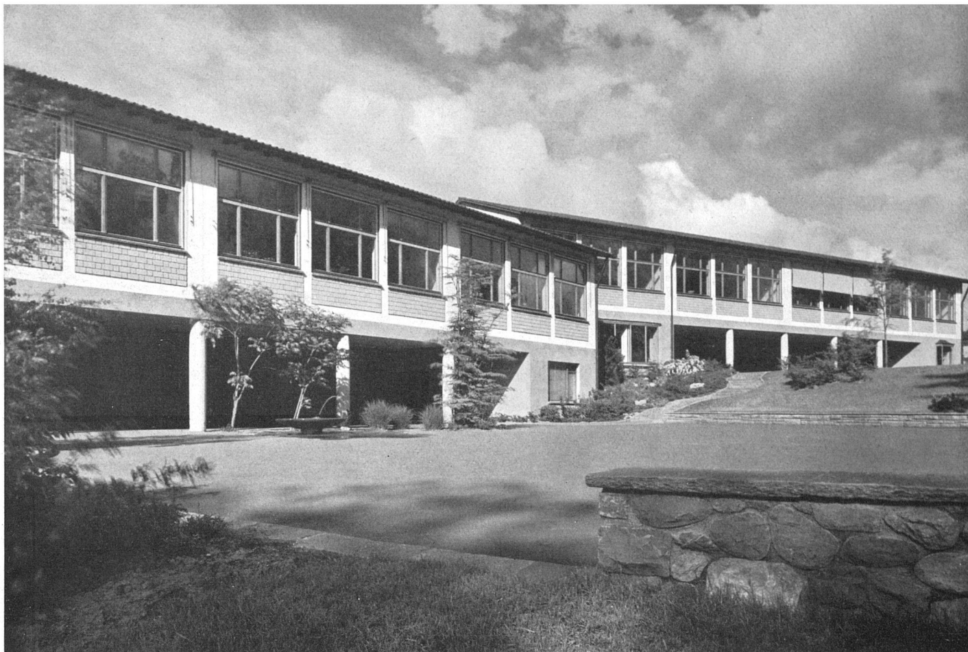
Teilansicht zweier Pavillons. Im Obergeschoß vier Klassenzimmer, im Erdgeschoß Spielhalle mit Pausenplatz | L'étage supérieur contient quatre classes rez-de-chaussée un préau ouvert et une place de jeu | Each wing has four classrooms in the upper story and a play hall with recreation area on the ground fl
