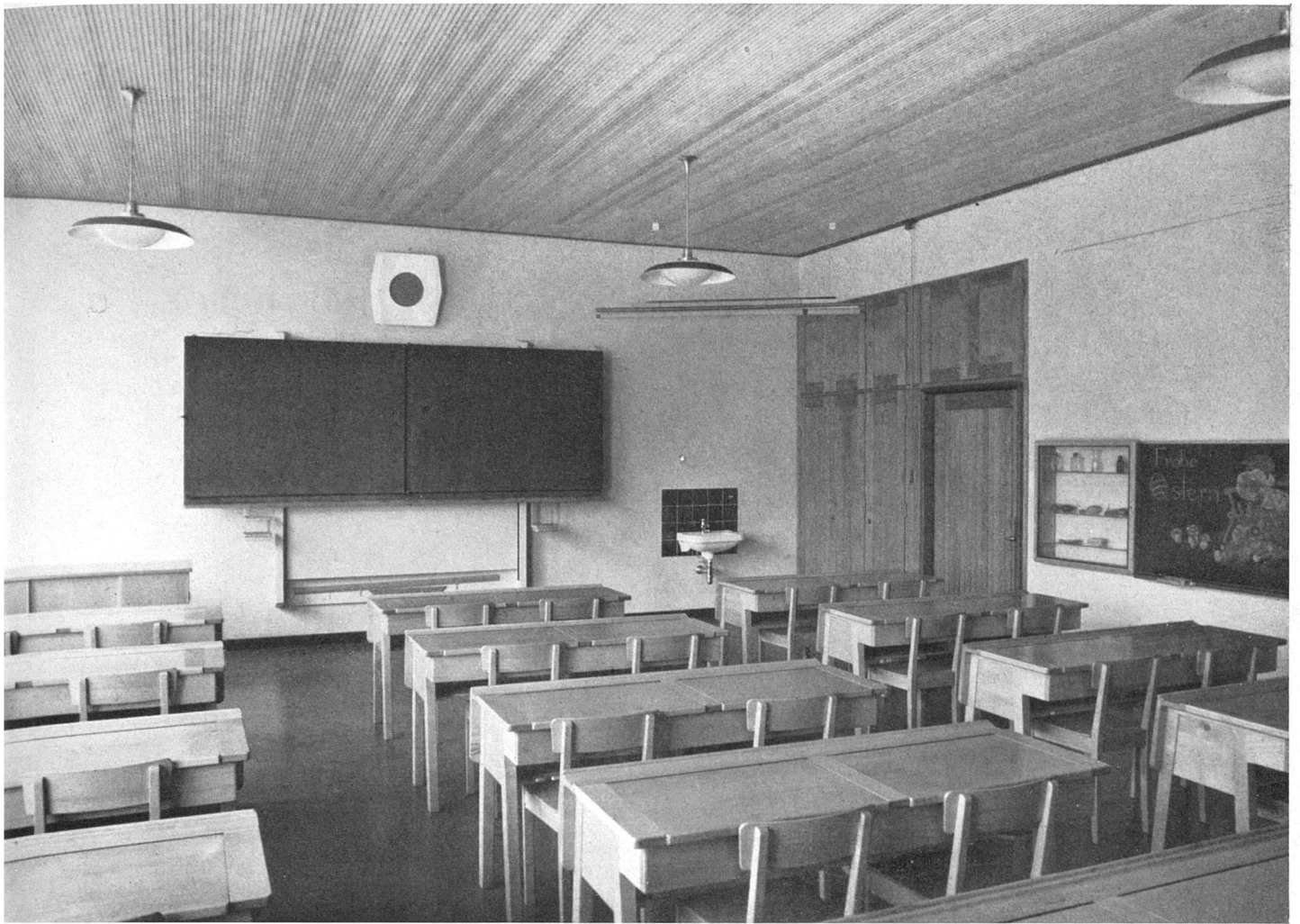
Klassenzimmer, Decke aus schallschluckender «Alimil»-Holzschalung / Salle de classe; plafond en bois / Classroom with patent acoustic wood ceiling
