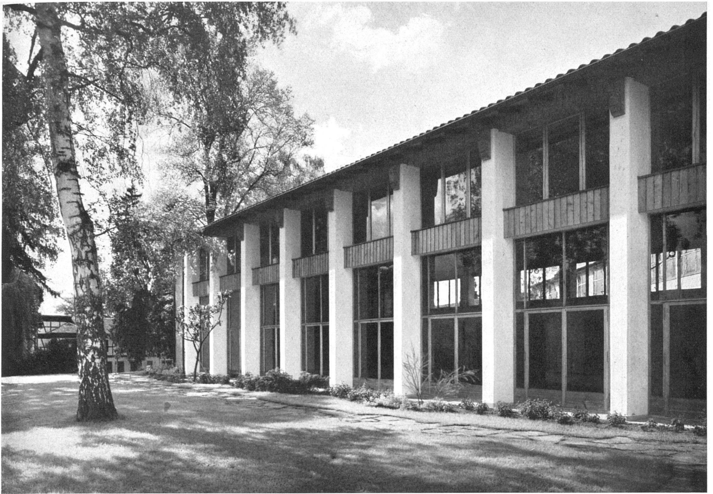
Turnhalle, Fensterfront und Doppeltüren mit splitterfreiem Sekuritglas, Fenster- und Türrahmen lasiert und lackiert | Salle de gymnastique; fenêtres et portes en verre «Securit», avec boiserie vernie | Gymnasium; windows and doors with «Securit» glass, window- and door-frames are varnished
