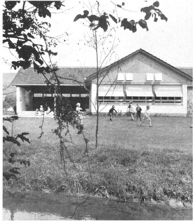
Südansicht, Oberlichter und Mittelpartie aus Thermoluxglas / Façade sud; fenêtre haute en verre «Thermolux» / South elevation, upper window with «Thermolux» glass
