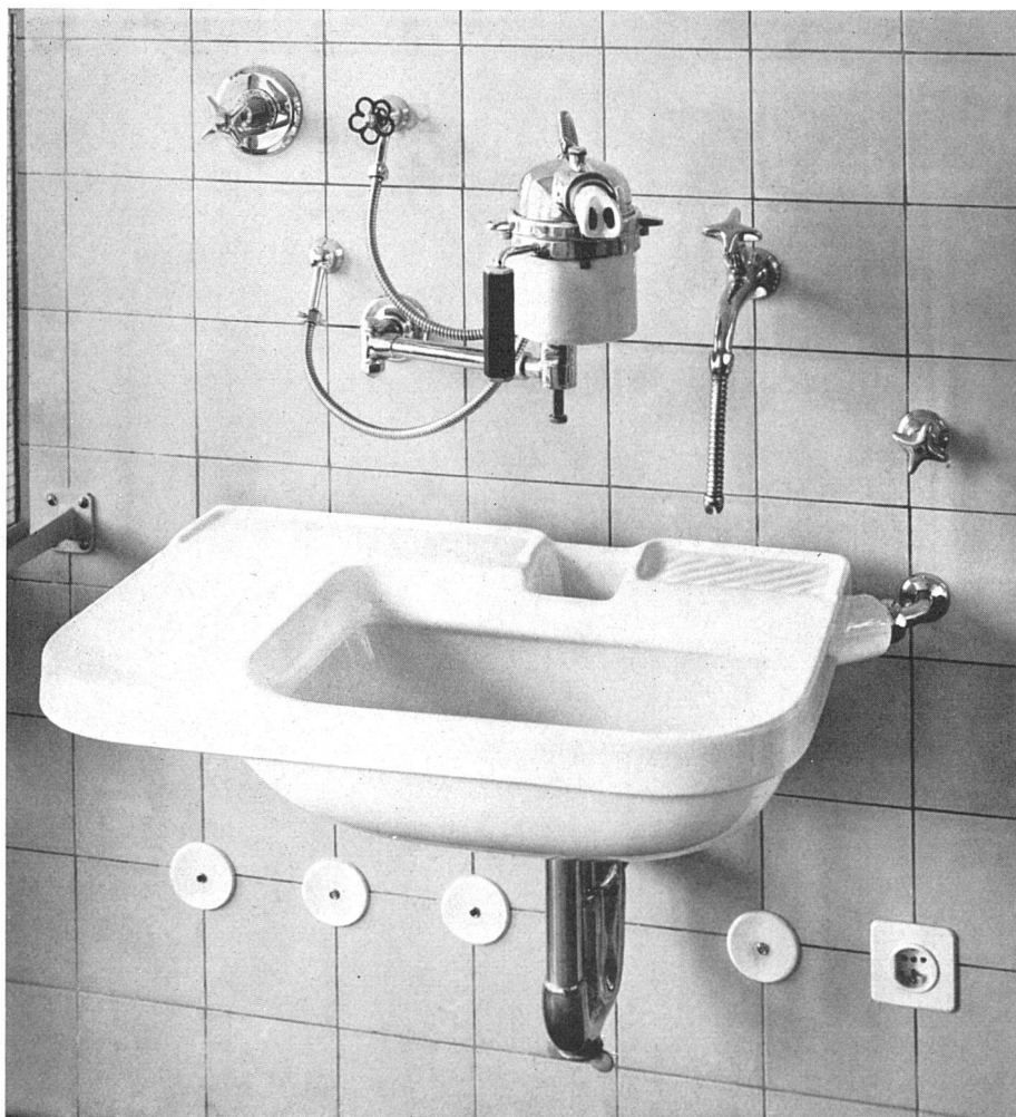
Spitaltoilette mit Inhalationsapparat. Dieselbe zweckgebundene Formqualität an Apparaten, Armaturen und Garnituren. Modelle: AKZ. Hersteller: AG. für Keramische Industrie, Laufen, und Aktiengesellschaft Karrer, Weber & Cie., Unterkulm (Schweiz) | Lavabo d'hôpital et appareil d'inhalation | Hospital toilet with respirator; apparatus, faucets and fittings of equal form quality, derived from function
