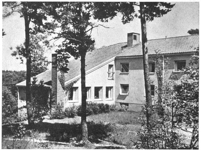
Heim für junge unverheiratete Arbeiter der Gustavsberg-Fabriken AG. 1943, Kooperativa Förbundets Arkitektkontor, Stockholm | Dortoir pour jeunes ouvriers célibataires | Dormitory for young unmarried workers
