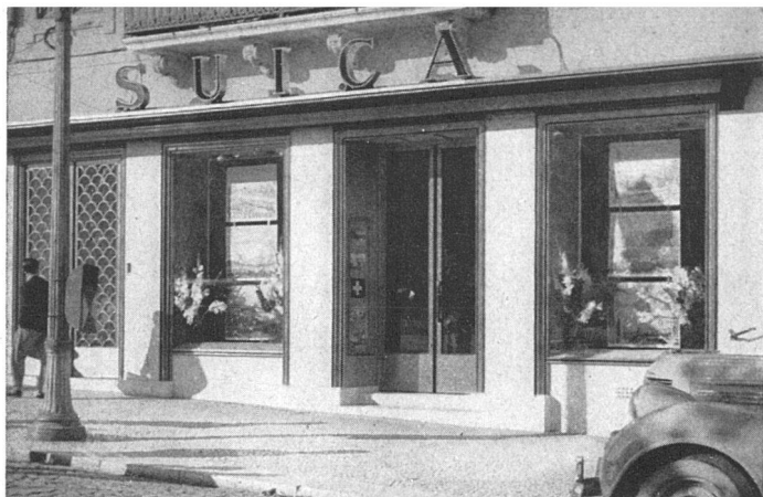
Straßenansicht / L'office vu de la rue / Street elevation
