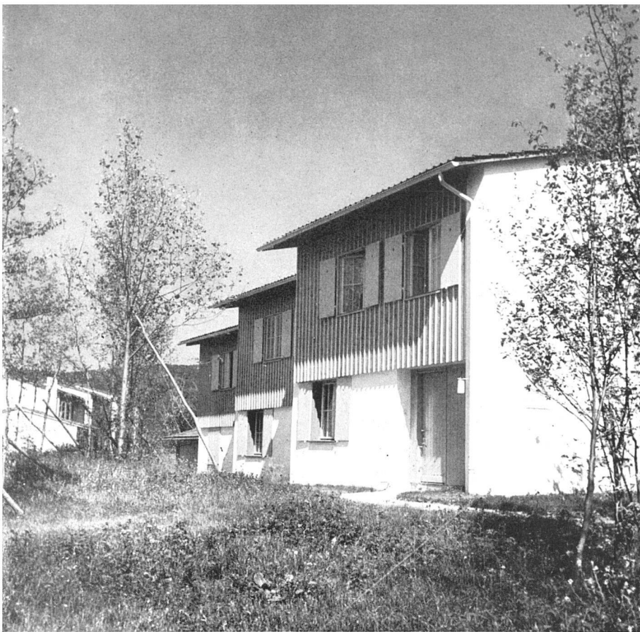
Hausreihe Typ E von Südwest, im Hintergrund Typ D / Rangée de maisons du type E vue du sud-ouest, à l'arrière-plan type D / Row house type E, view from south-west, in the background type D
