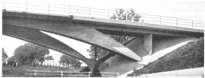
Robert Maillart, Straßenüberführung bei Allendorf (Kt. Schwyz), 1940
