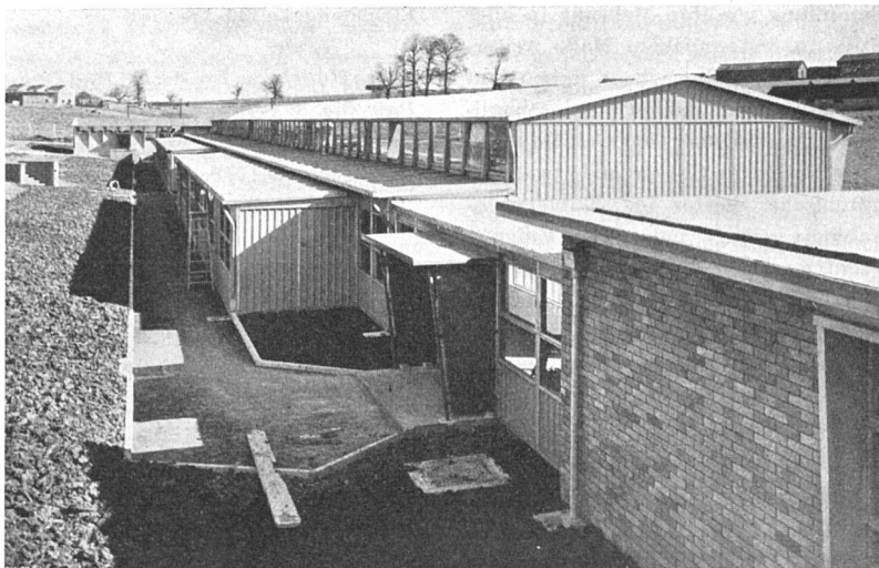
Schule in Bristol aus vorfabrizierten Aluminium-Elementen. Rückansicht
