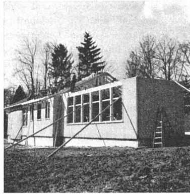
Der Pavillon im Bau (Montagebauweise)
