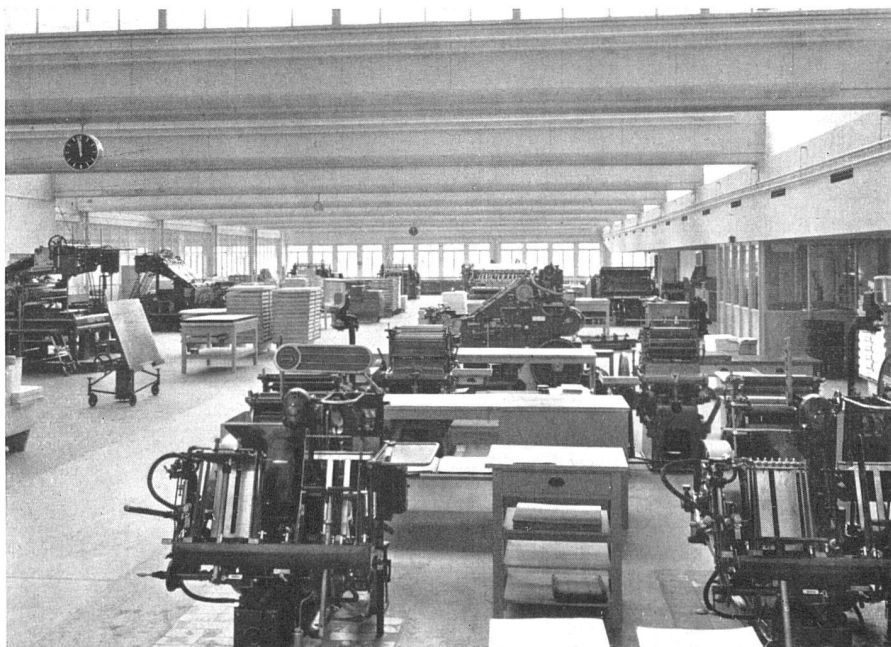
Druckerei-Maschinensaal. Verkehrsflächen roter Spezialzement, übriger Bodenbelag Asphaltplatten und Klinker | Salle des machines. Plancher en briques hollandaises et asphalt. Les endroits exposés au trafic sont en ciment rouge spécial | Printing-machine room. Passage ways of red special cement, remaining flooring asphalt slabs and clinkers
