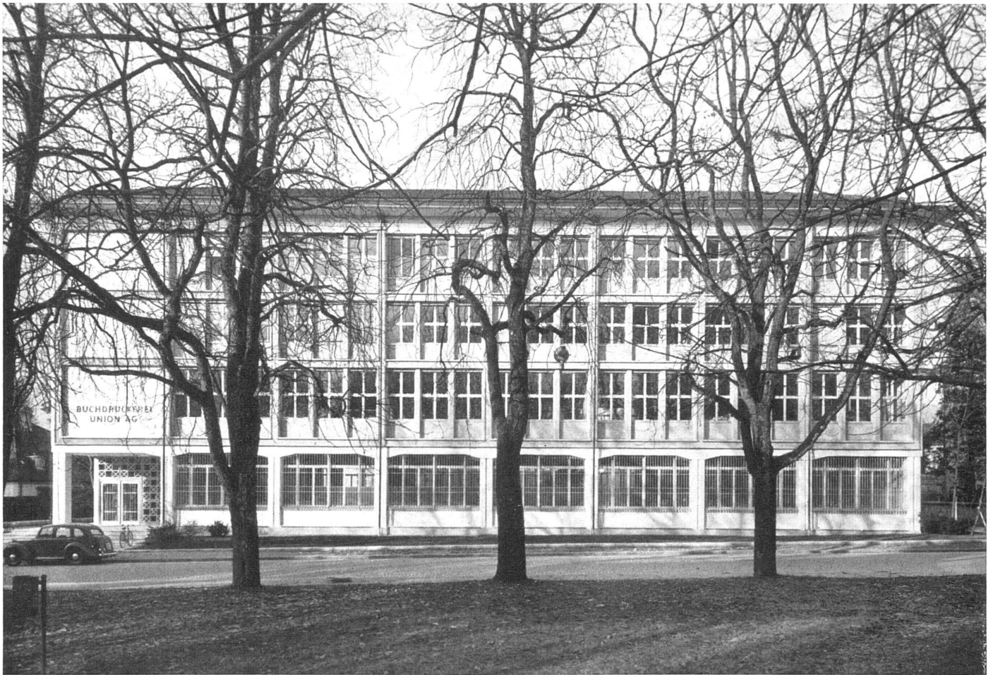
Südost-Fassade. Betonskelett in den oberen Stockwerken mit Kunststein verkleidet, Brüstungen Eternit mit Anticorodal-Wetterschenkeln abgedeckt | Façade sud-est. Squelette de béton. Les étages supérieurs sont recouverts de simili-pierre. Parapet en éternite et renvoi d'eau recouvert d'anticorodal | South-east elevation. Concrete skeleton, in the upper floors faced with artificial stone. Sills Eternit, covered with anticorodal weather boards Photos: Heri, Solothurn
