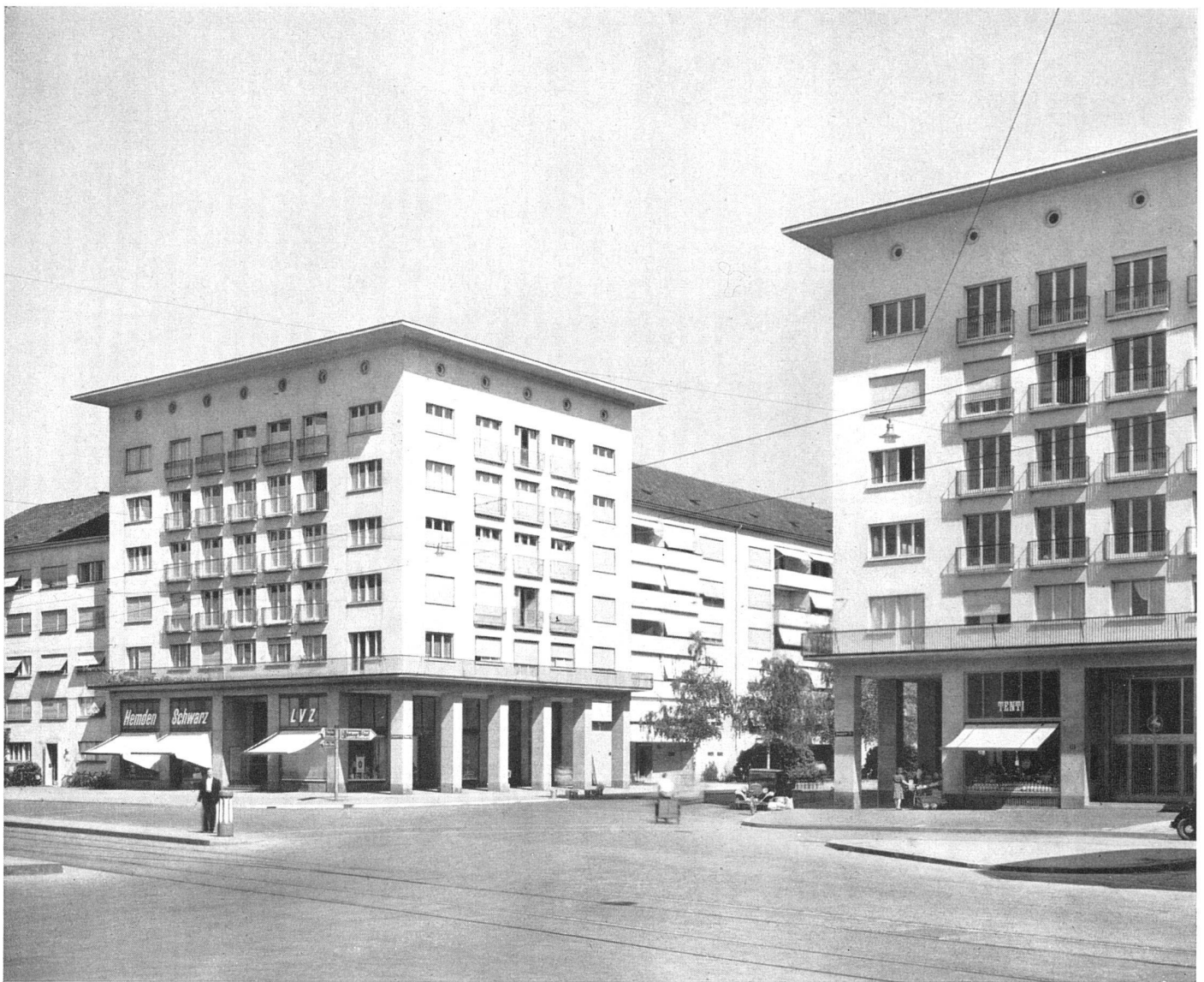
Gesamtansicht | Vue générale | General view
