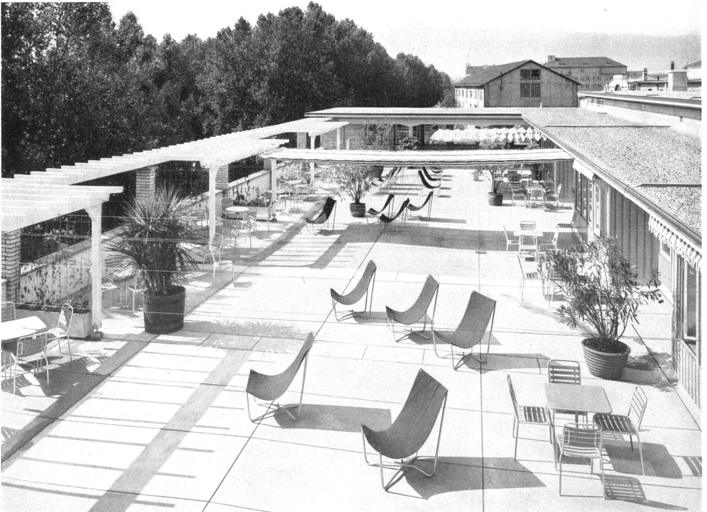
Dachterrasse | Vue supérieure du toit-terrasse | Roof-garden
