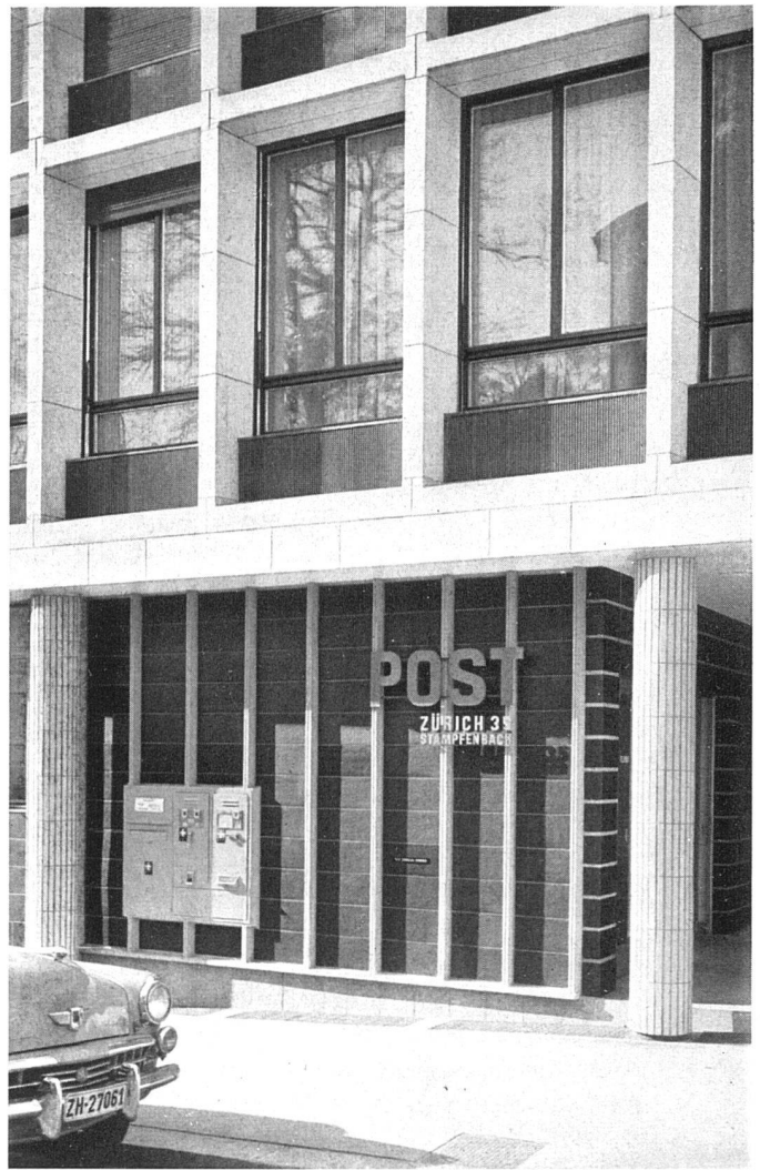
Fassadendetail. Pfeiler mit Kunststeinverkleidung, Brüstung Keramik grün | Détail de façade. Pilier à revêtement simili-pierre, contre-cœur en céramique verte cannelée | Detail of façade. Pillars with artificial stone facing, breastwall in green ceramic. Photo: M. Wolgensinger SWB, Zürich
