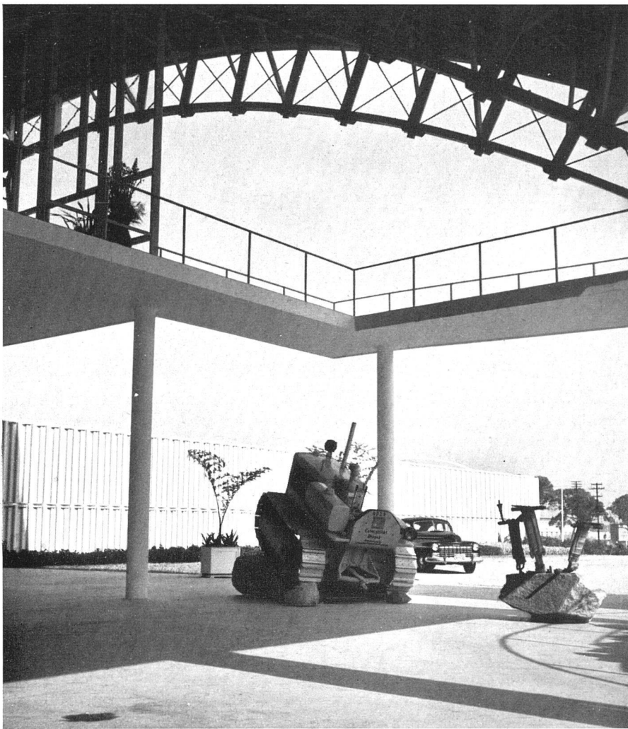
Blick unter der Besuchergalerie hindurch gegen Bürotrakt | De la galerie des visiteurs la vue porte jusqu'au bâtiment administratif | View beneath visitors' gallery towards office wing Interphoto News Pictures, Overseas-Press
