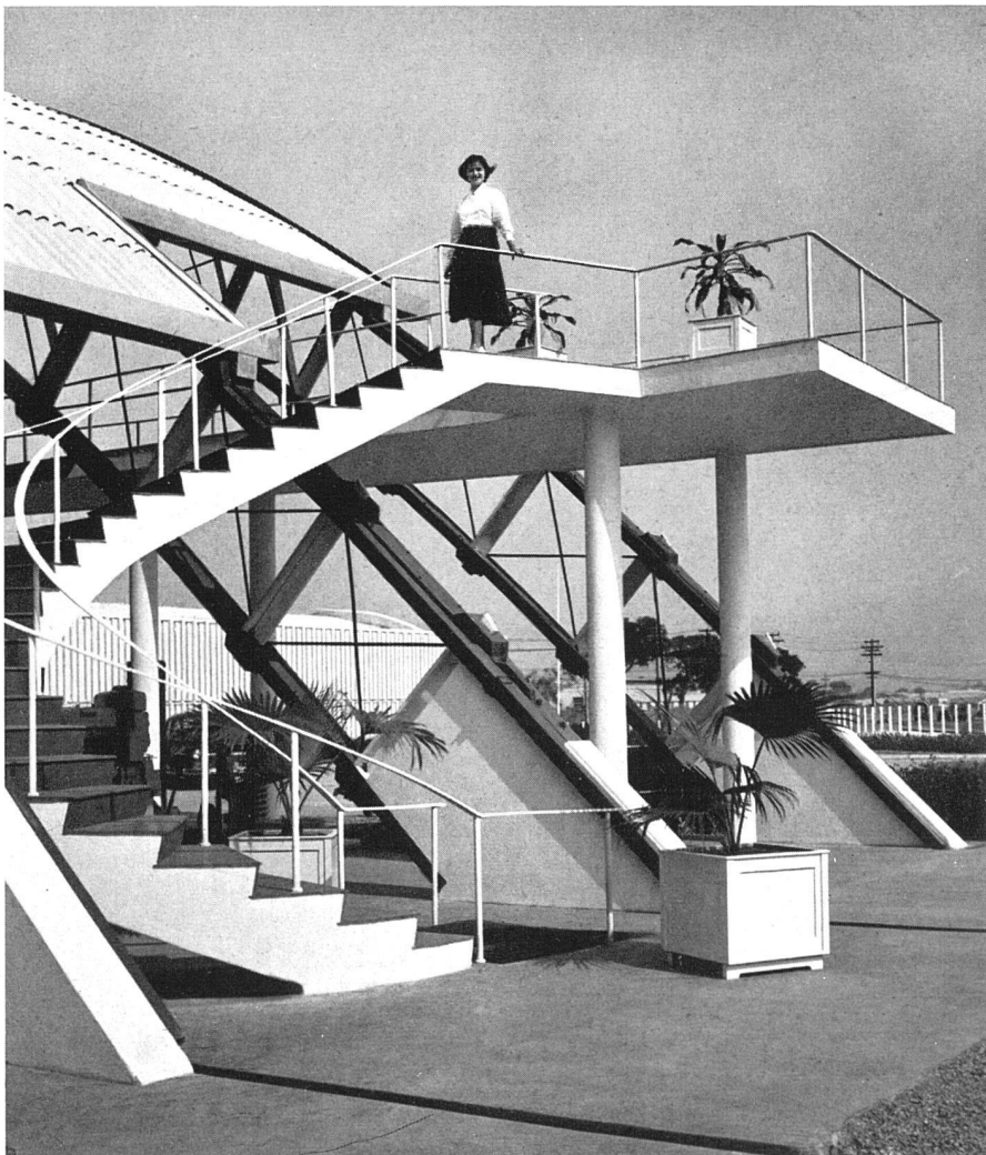
Besuchergalerie und Dachkonstruktion sind getrennt gestützt | Le toit et la galerie ont des assises différentes | Visitors' gallery and roof construction have completely separate supports
