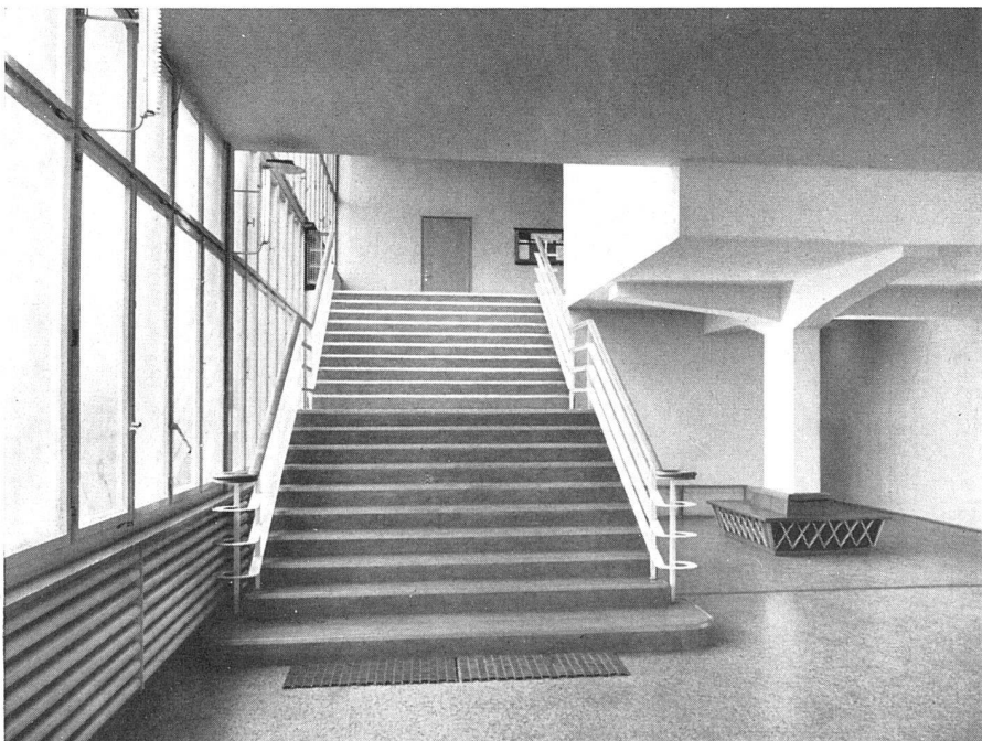
Treppenaufgang zum großen Saal | Escaliers menant à la grande salle | Stairway leading to large club room
