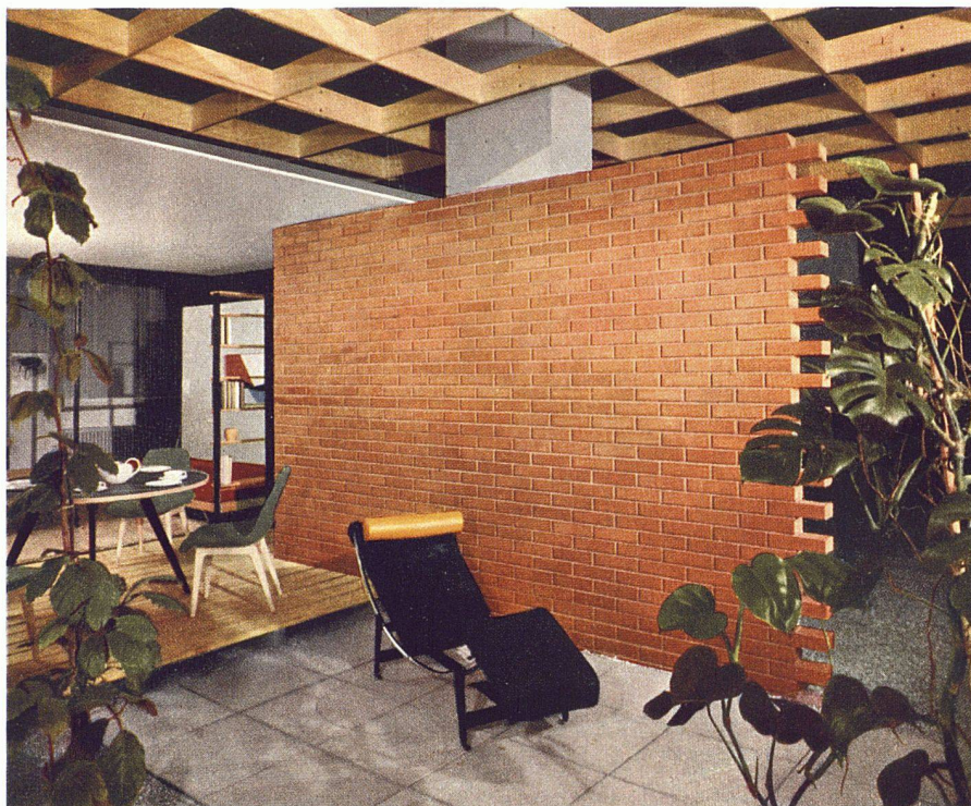
Sichtmauerwerk mit Normal-Backsteinen 25|12|6 cm, aus dem Tonwerk Döttingen, der A.G. Hunziker & Cie.
