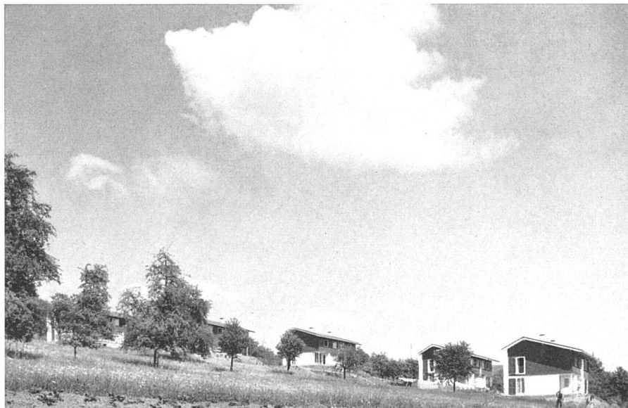
Die Siedlung von Westen. Die Wohnungen sind durch Fenstertüren mit den seitlich angrenzenden Baumgärten ebenerdig verbunden | La colonie vue de l'ouest | The colony seen from the west Photo: Myriam Früh
