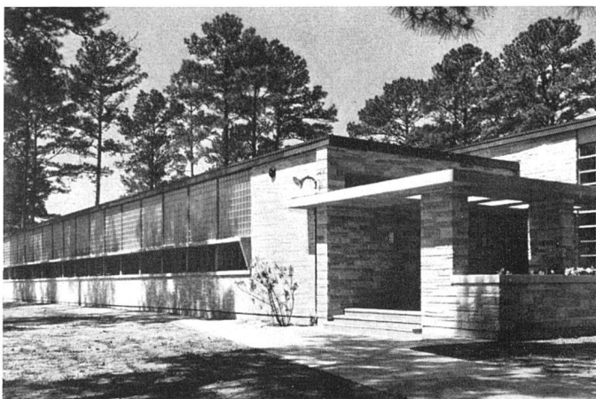
Schule in Houston, Texas. Außenansicht, durchsichtiges Fensterband mit Vordach | Vue extérieure | Outer view of the school Golemon & Rolfe, Arch.
