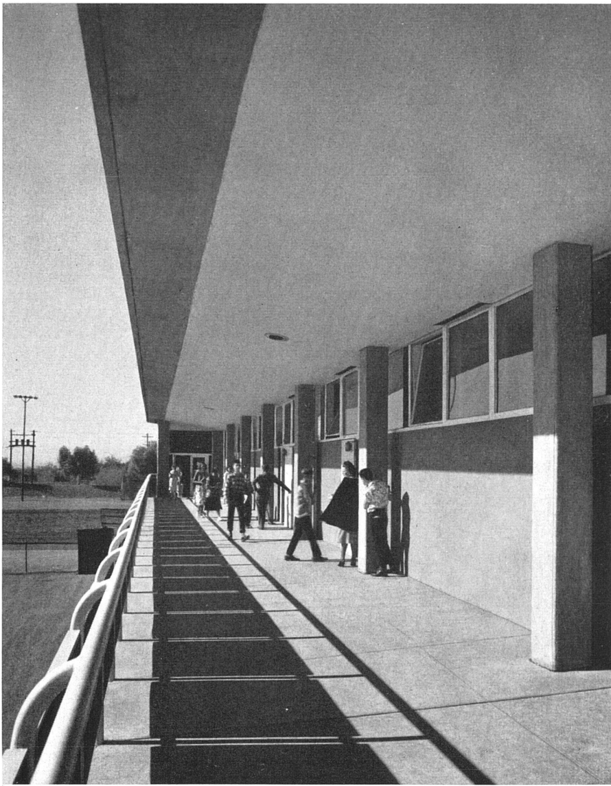
Laubengang, der die nach Süden orientierten Seitenoberlichter abschirmt | Galerie découverte, protégeant les fenêtres contre le soleil | Open corridor access
