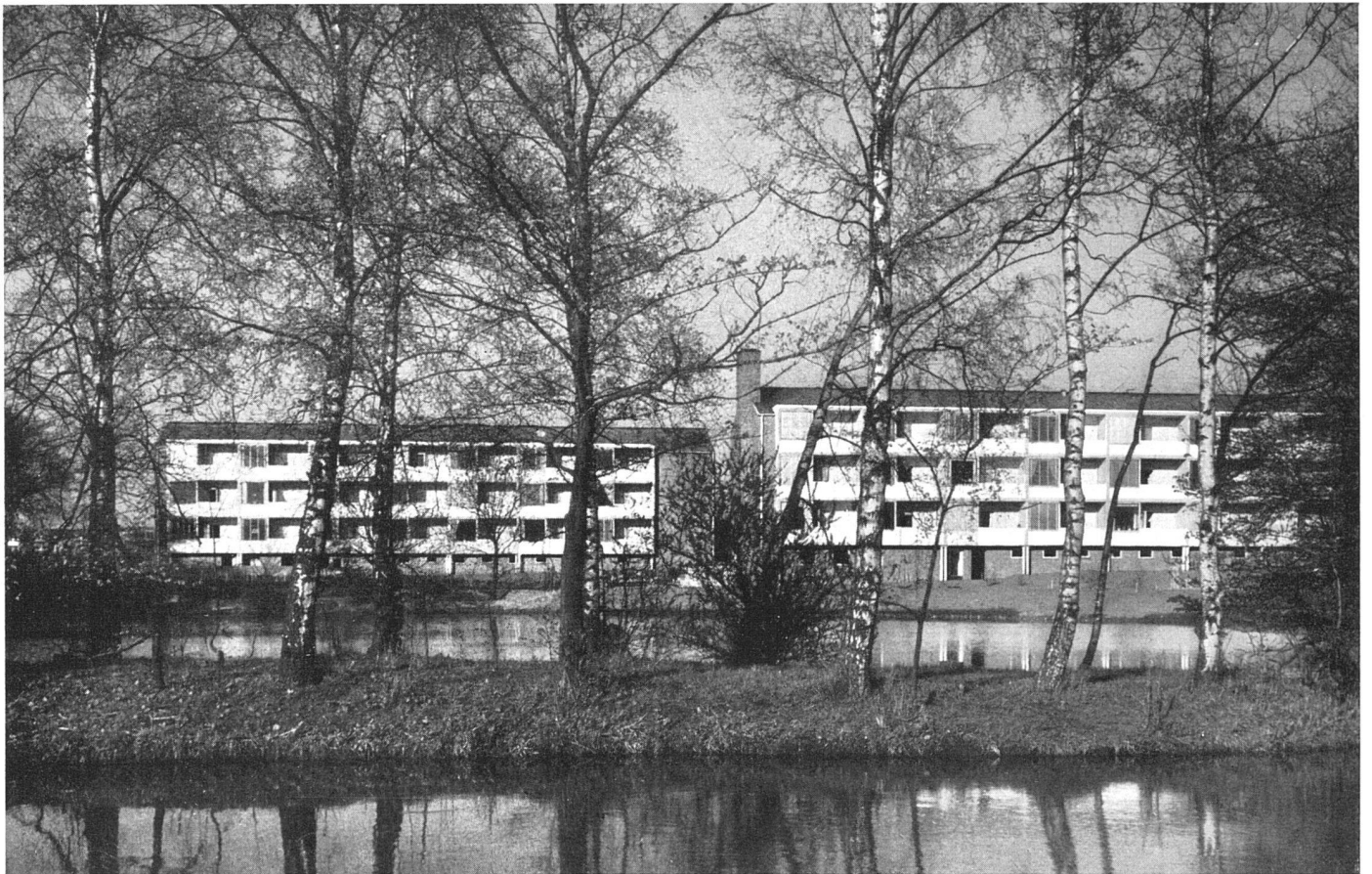
Gesamtansicht von Süden | Vue générale prise du sud | General view from the south
