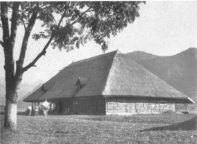
Einfacher, gesunder und billiger Schweinestall (Linthebene). Konstruktion: Rundholz, Schilfdach, Strohballen | Une porcherie de construction simple et à bon marché | A simple and cheap pigsty
