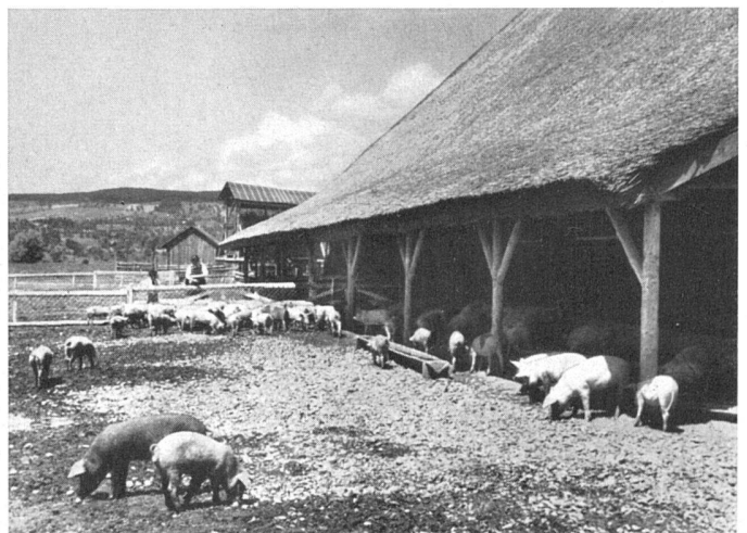
Einfacher, gesunder und billiger Schweinestall (Linthebene). Konstruktion: Rundholz, Schilfdach, Strohballen | Une porcherie de construction simple et à bon marché | A simple and cheap pigsty
