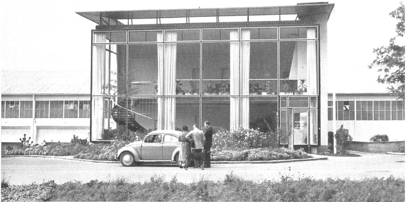
Ansicht des Zentralgebäudes von der Kantonsstraße, im Hintergrund die Montagehalle | Vue du bâtiment central depuis la route cantonale, au fond la halle de montage | View of central building from Kantonsstraße, in the background the assembly shops
