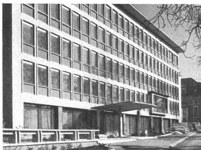
Erweiterungsbau des Physikalischen Institutes der ETH, Zürich, Gloriastraße, 1950. L. Boeckler und F. Metzger, Arch. BSA
