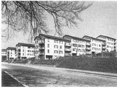
Überbauung an der Wasserwerk-Imfeldstraße, Baugenossenschaft des eidgenössischen Personals, 1944/47. Aeschlimann und Baumgartner, Arch. BSA
