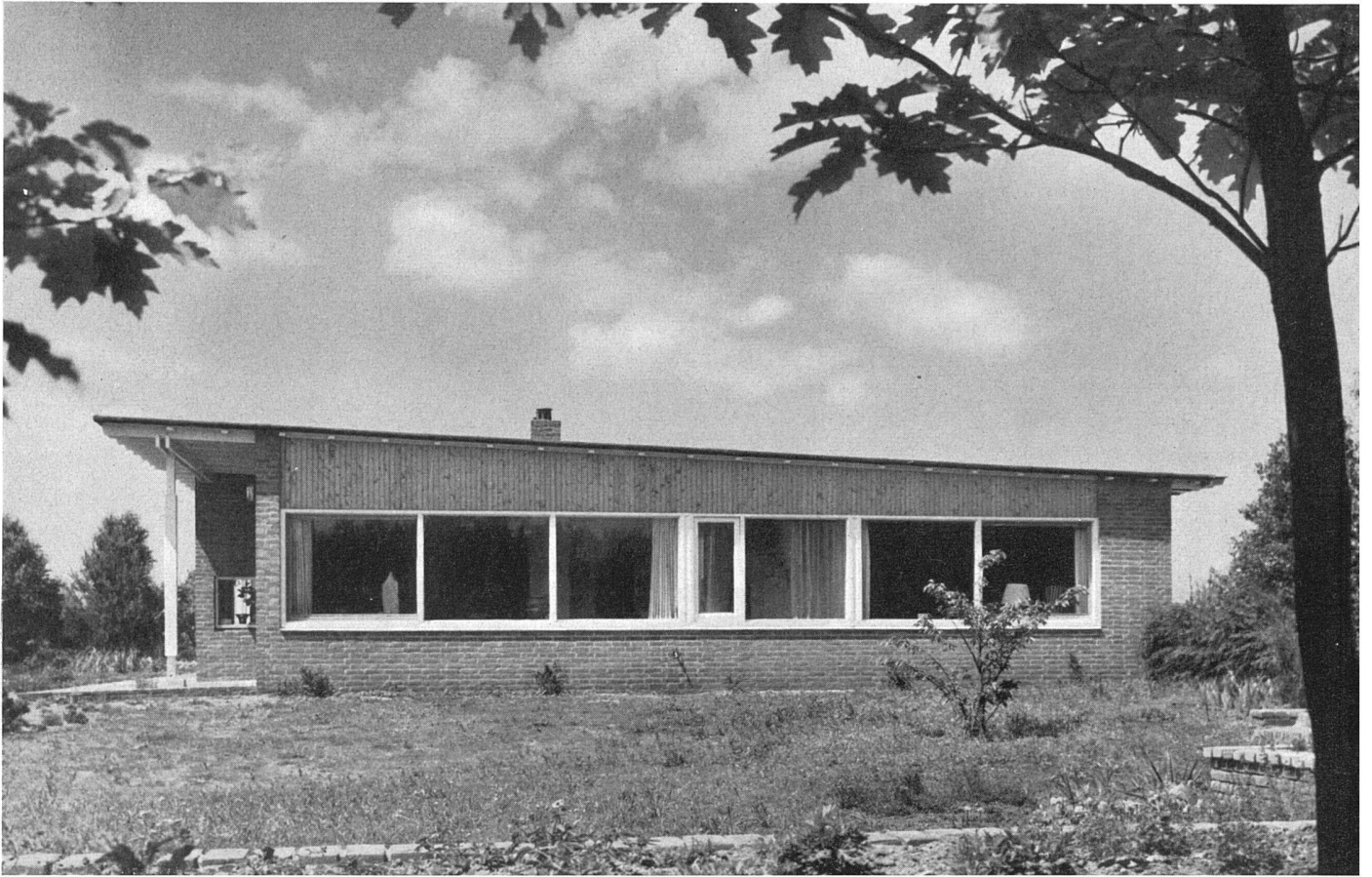
Ansicht von Osten | Façade est | East elevation
