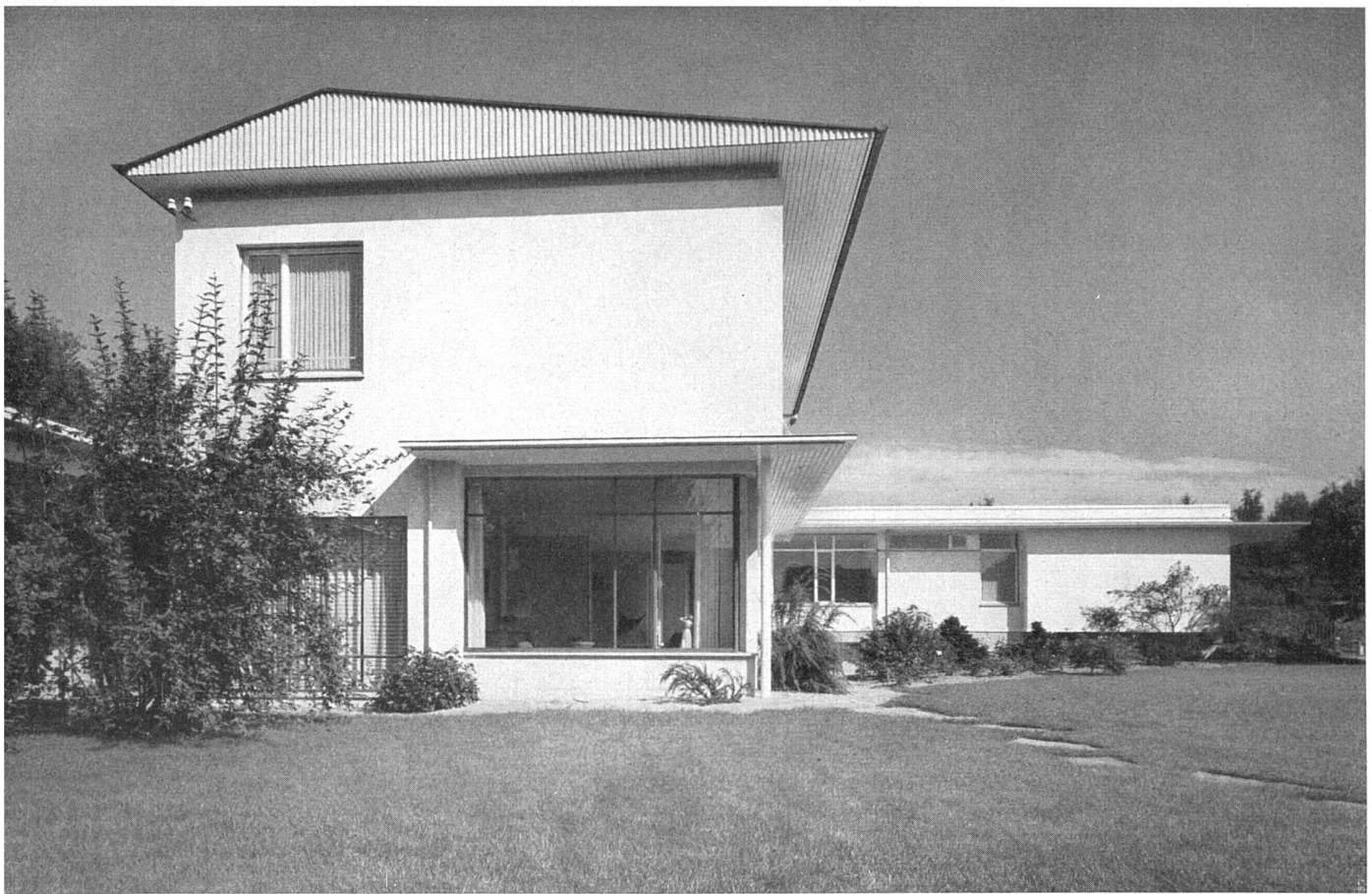
Ansicht des Wohnhauses von Westen, Giebelverschalung aus Welleternit | La maison vue de l'ouest | West elevation, in the background the new parents' wing Sämtliche Photos: M. Wolgensinger SWB, Zürich
