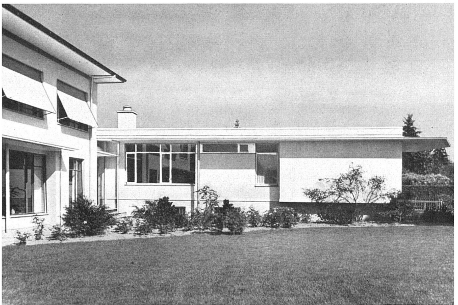
Westansicht des Ostflügels | Façade ouest de l'appartement des parents | West elevation of the parents' wing
