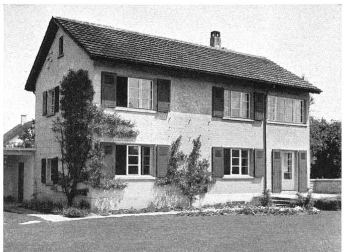
Das alte Wohnhaus vor dem Umbau | L'ancienne maison avant sa transformation | The old house before remodelling
