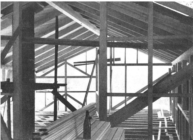
Schon der Rohbau zeigt die künftige Form des Innenraumes | La charpente indique déjà la future forme de l'intérieur | In the unfinished construction the future form of the interior can already be seen
