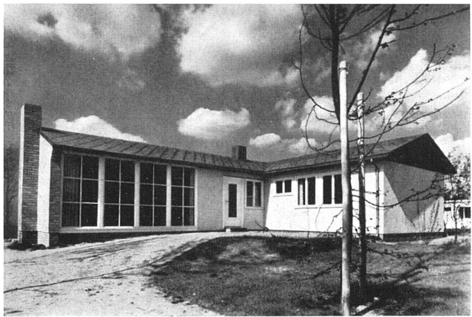
Einfamilienhaus in Tafelbauweise. Prof. G. Hassenpflug, Arch. BDA, Hamburg. Wandvollplatten 125 \times 250 cm, verputzt. Eternitdach | Maison fait d'éléments préfabriqués | House made of prefabricated wall elements
