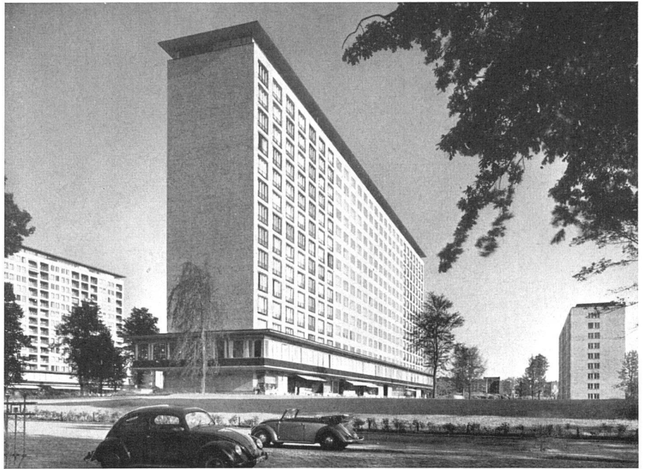
Gesamtansicht von Nordwesten, im Hintergrund 8-geschossiger Bau | General view from north-west
